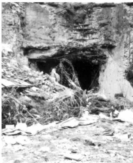
Разрушенный дот в районе высадки десанта
