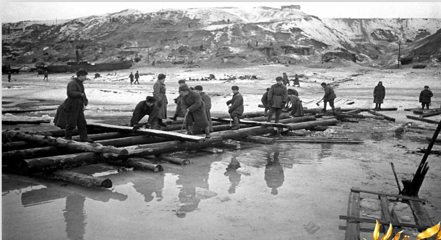
Инженерно-строительные войска строят переправу через Волгу, декабрь 1942 года.
