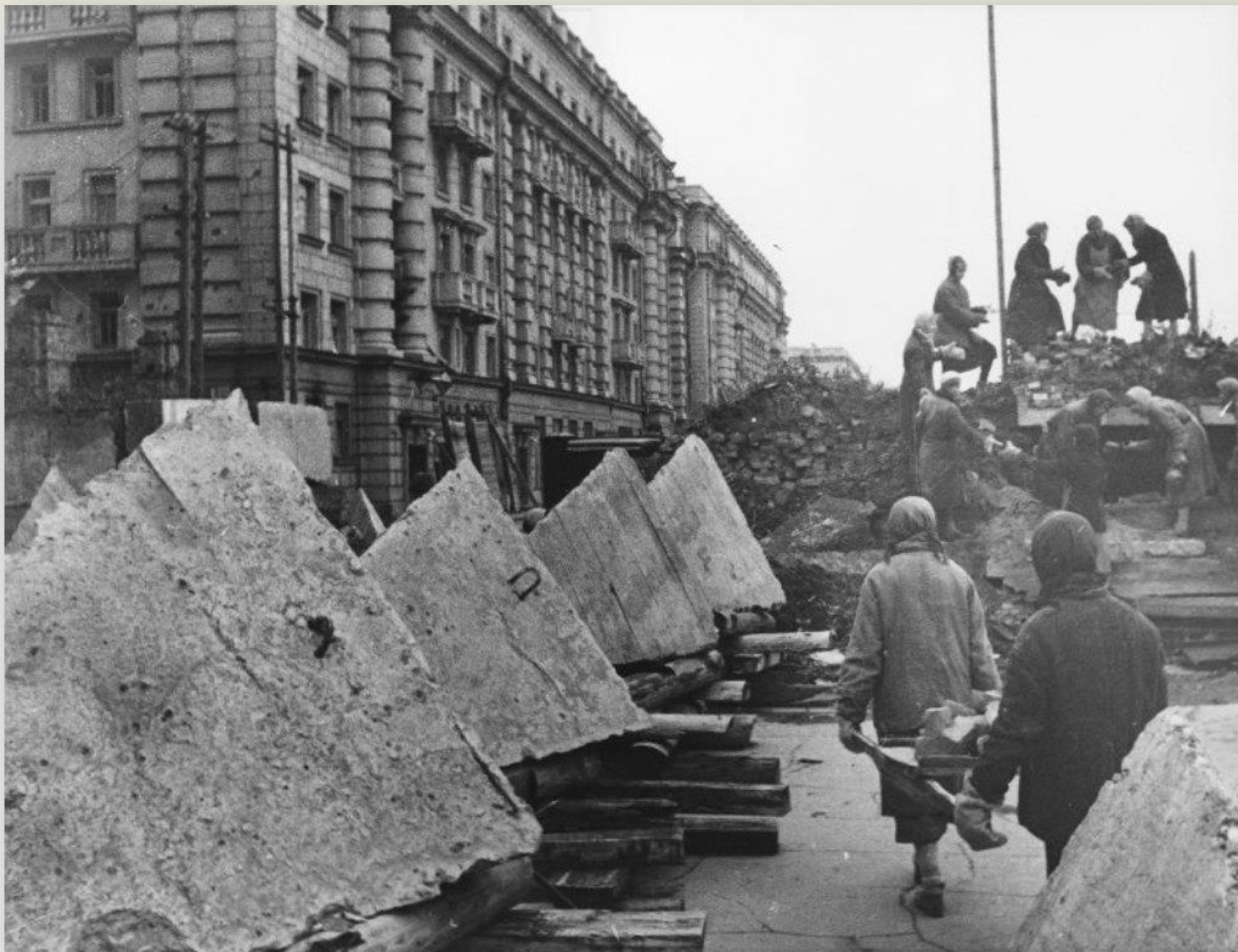
Строительство оборонительных сооружений в Ленинграде
