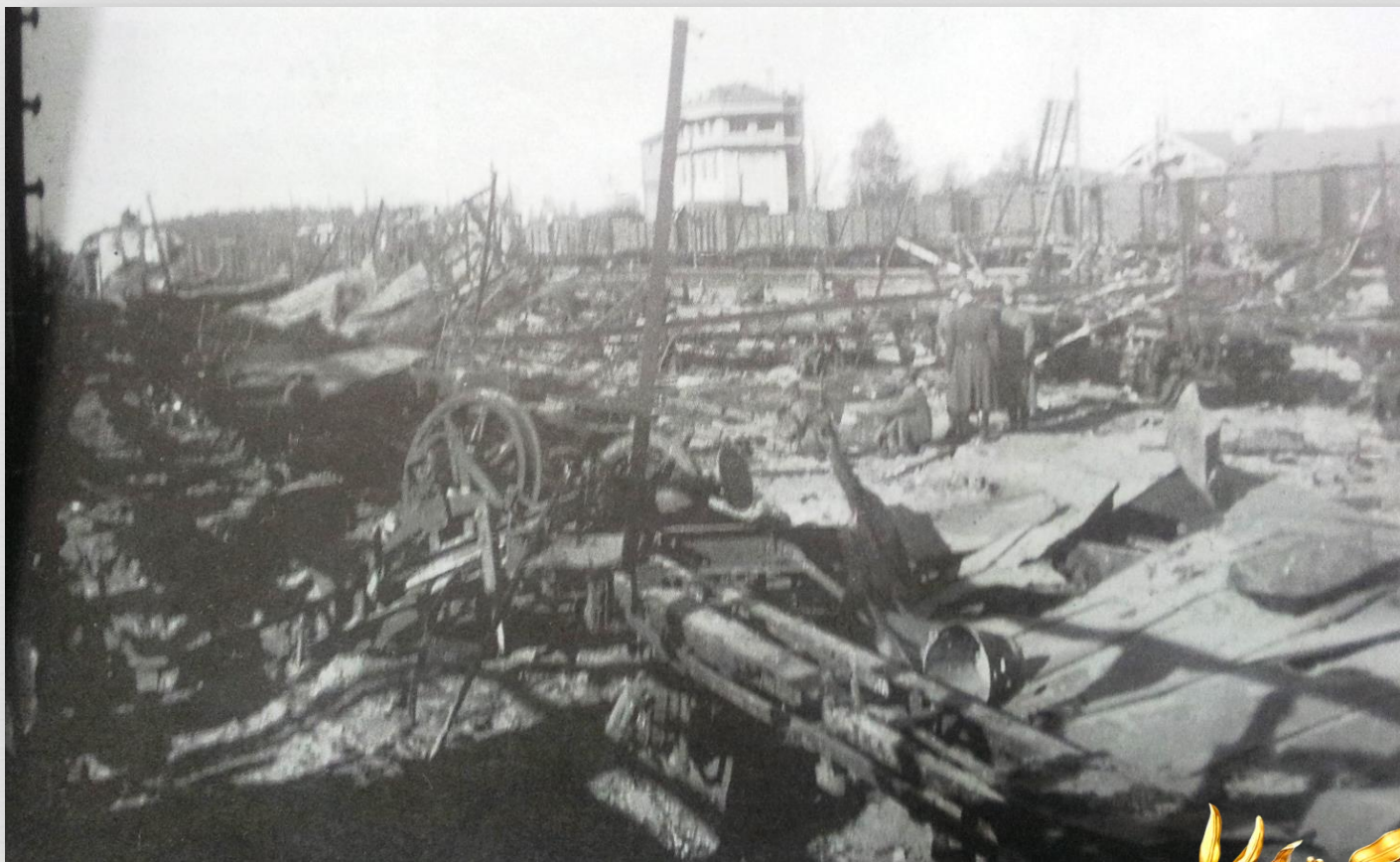
Разрушенная станция Мга. 1941 г.
